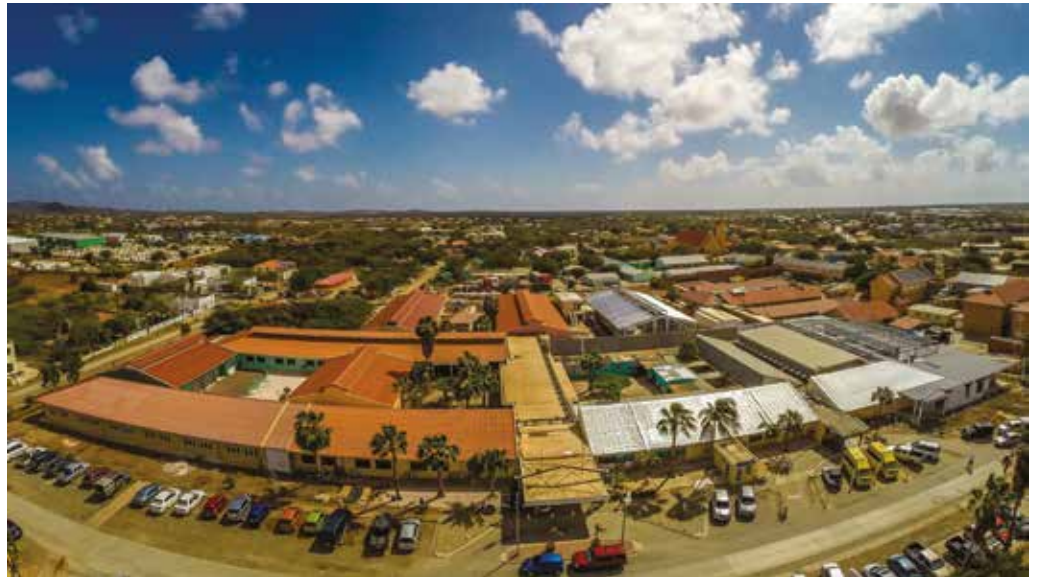
Ziekenhuis tijdens de ver- nieuwbouw
