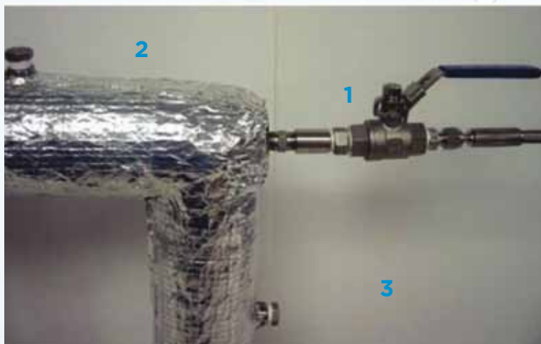
Figuur 1: Plaatsing aftappunten in leiding
